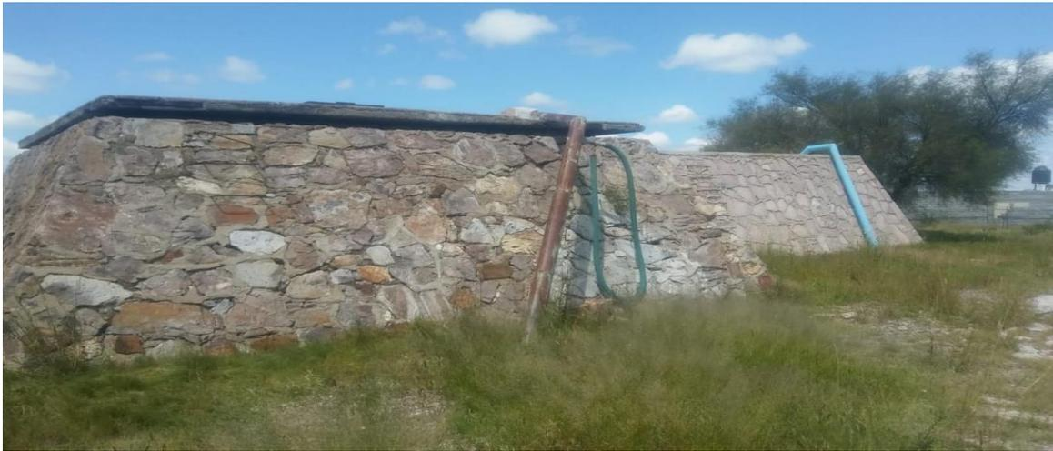
**Pozo Chupaderos:** Con una profundidad de 196 m. aproximadamente, trabaja las 24 hrs., el equipo de bombeo es de 30HP, la tubería de columna es de 3" de diámetro y la producción es de 10 lps.
