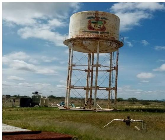
**Pozo Bañón:** Con una profundidad de 282 m. aproximadamente, trabaja las 24 hrs., el equipo de bombeo es de 75HP, la tubería de columna es de 6" de diámetro y la producción es de 22 lps.
