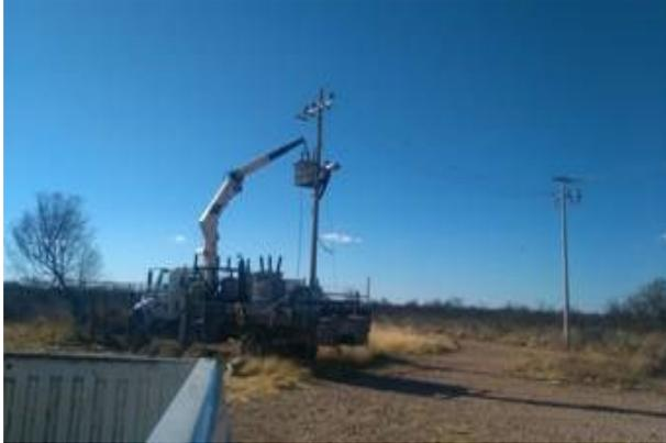
Se trabajó en el Sistema de Agua Potable de la **Localidad de Tierra y Libertad** en las acciones de Mantenimiento correctivo a equipo de bombeo, al transformador eléctrico y al sistema eléctrico del pozo.
